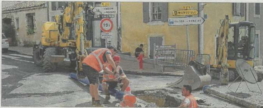
Les travaux ont démarré en face de l'hôtel du Midi.
