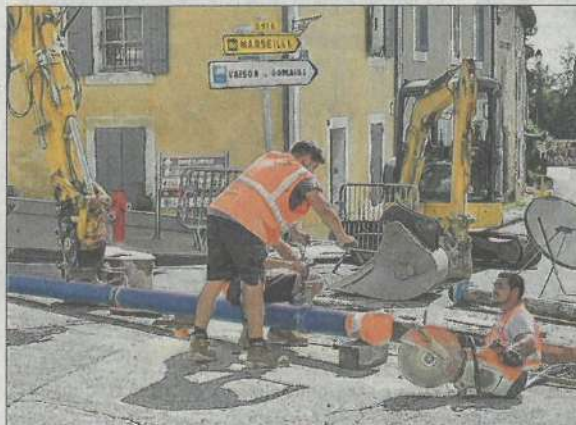
Les travaux d'adduction d'eau réalisés par le syndicat intercommunal Rivavi, sous maîtrise d'ouvrage de la mairie, vont se poursuivre jusqu'au mois de novembre. Photo Le DL/L.D.
