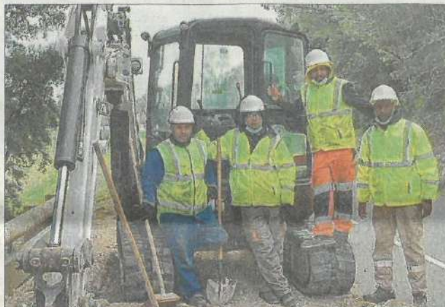
Les employés de Loca Com travaillent au déploiement de la fibre route de Richerenches. LeDL/L.D.
