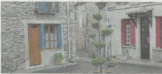
Le n° 16 à gauche devrait se retrouver rue de Bellevue. Le numéro 6 à droite ne change pas.
