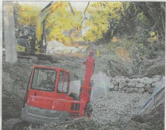
Travaux sur les berges et le lit du Talobre pour éviter l'érosion et protéger la canalisation de gaz.
