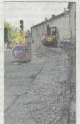
Les travaux de remplacement des canalisations d'eau potable se terminent.
