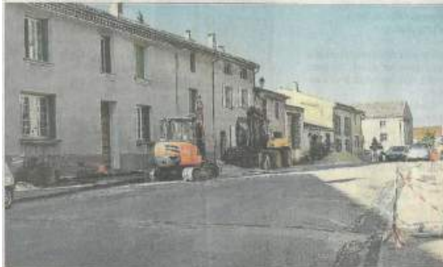
Les travaux sur l'avenue des Alliés ne concernent que le réseau d'eau potable.
